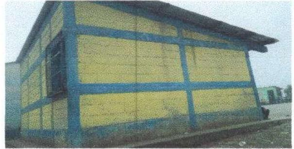
Foto 8: Repello en paredes para que no filtre la humedad
