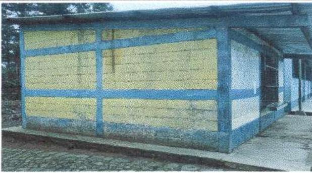
Foto 9: repello en la pared para que no pase humedad
