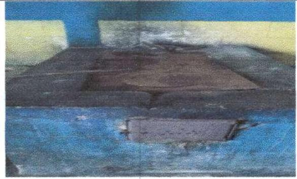
Foto 2: Sustrucción de 2 planchas de leña en mal estado
