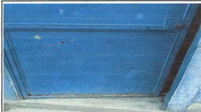
Foto 3: Sustrucción de puerta de cocinapor desgaste, no abre ni cierra bien
